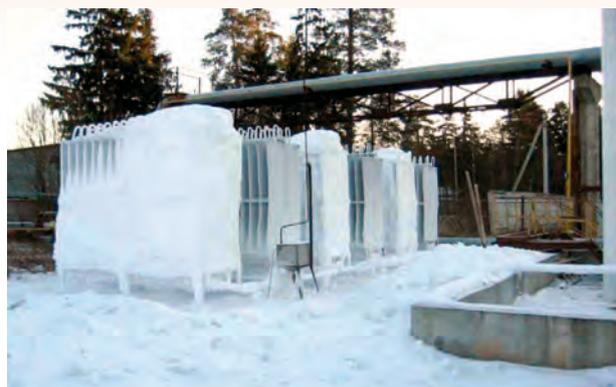
Рис. 1. Атмосферные испарители в осенне-зимний период эксплуатации
